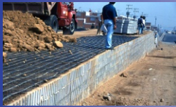
MUROS DE SUELO ARMADO CON REFUERZOS SINTÉTICOS Y DISTINTOS ELEMENTOS DE FACHADA
