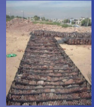
Gaviones y colchonetas resistentes a corrosión
