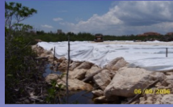
Filtro sintético para separación, filtración y prevención de la erosión de suelos
