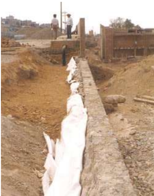
Fig. 5 Drenaje de muro: grava protegida con geotextil PAVITEX filtrante.
