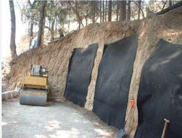
Fig. 7 Colocación de un geodren prefabricado PAVIDREN entre el suelo reforzado y el suelo retenido, como parte del sistema de drenaje de un MEM.
